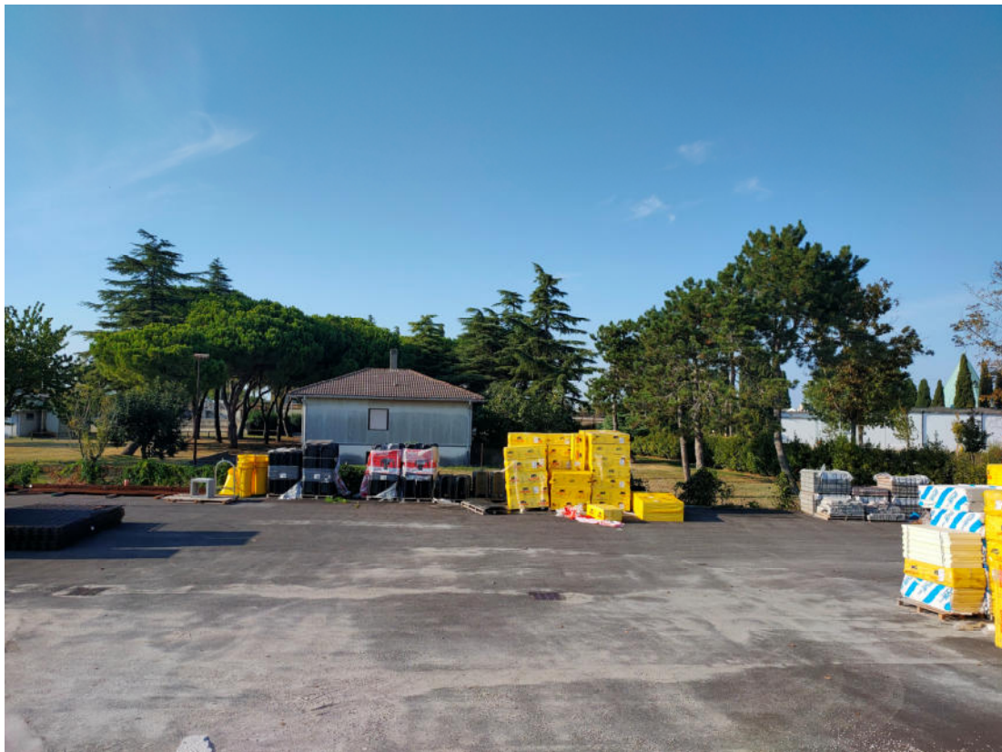
Foto dal lato sud dal deposito materiali edili a confine.
